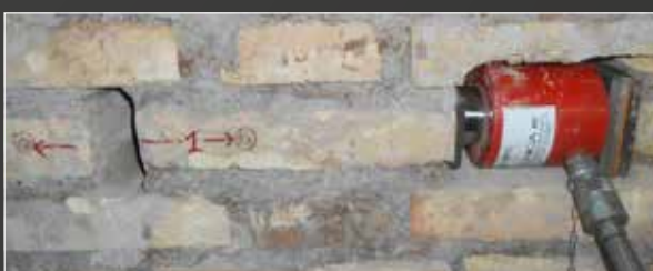
PROVA SHOVE TEST PER RILIEVO \tau MURATURA
