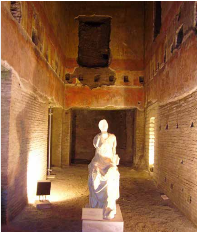
"DOMUS AUREA", ROMA - CAMPAGNA DI INDAGINE SU MURATURE PORTANTI
