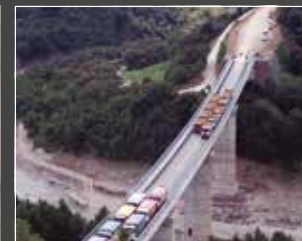
COLLAUDO VIADOTTO - CAGLIARI
