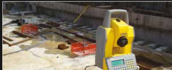
MONITORAGGIO CON STAZIONE TOTALE PARCHEGGIO INTERRATO DI PIAZZA CAVOUR, ROMA
