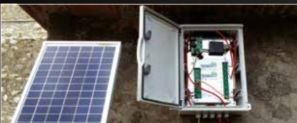
CENTRALINA AUTOMATICA PER MONITORAGGIO STRUTTURALE E GEOTECNICO
