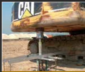
PROVA DI CARICO SU PIASTRA
