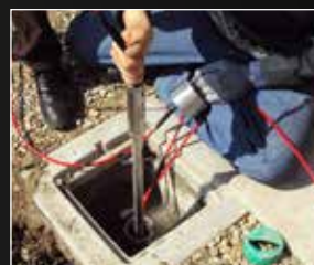
MONITORAGGIO GEOTECNICO IN AUTOMATICO
