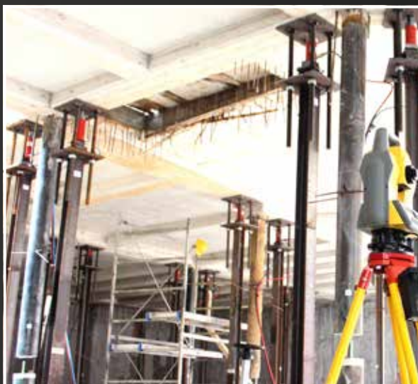
SOLLEVAMENTO CON MARTINETTI OLEODINAMICI SOLAIO BIBLIOTECA "MARIANUM", ROMA
